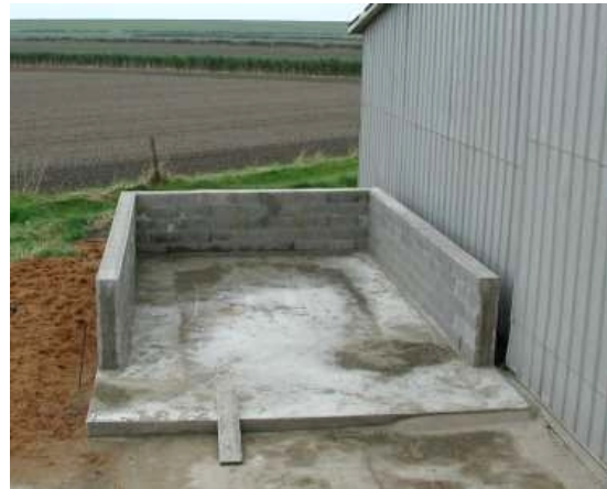
Festmistplatte; eine Rückhaltung für Jauche, inklusive Niederschlagswasser, fehlt!
