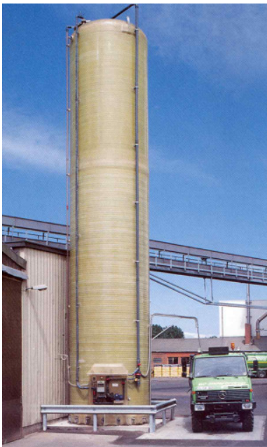
GfK-Behälter, doppelwandig und Abfüllplatz [Quelle: Geschwill]
