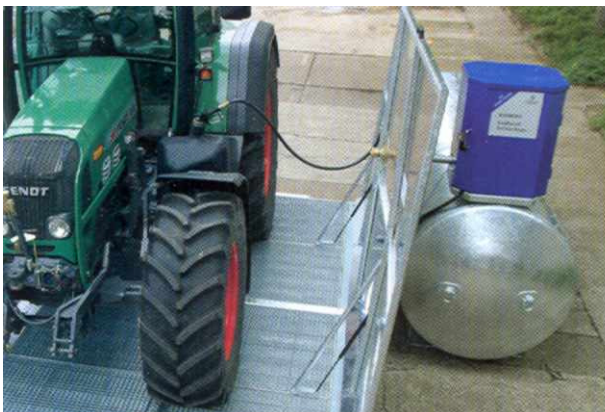
Tankstelle in Betrieb; ohne Anfall von Niederschlagswasser
