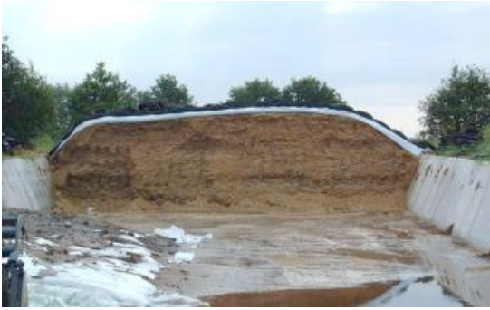
Fahrsilo „Traunsteiner Bauart“
