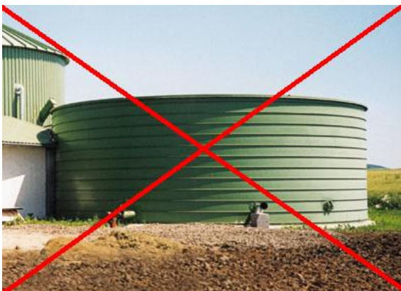
Güllebehälter; tief liegende Wanddurchdringungen sind nicht zulässig; die Entnahme muss über die Behälterwand erfolgen!
