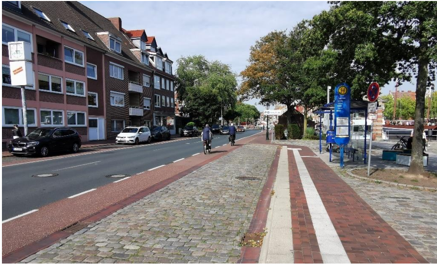
Abbildung 2: Typisches Beispiel für den Haltestellenausbau in Emden (Haltestelle Am Delft, Ostseite)
