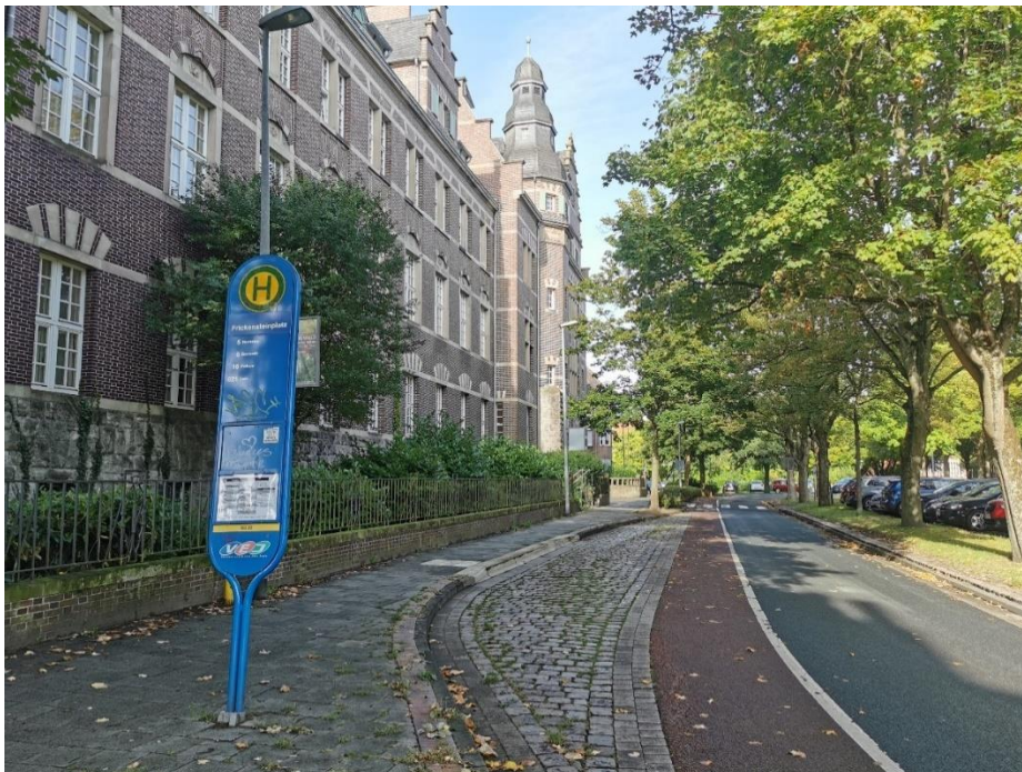
Abbildung 20: Haltestelle mit zu schmalem Gehweg für Rollstuhlnutzende (Beispiel: Haltestelle Frickensteinplatz)
